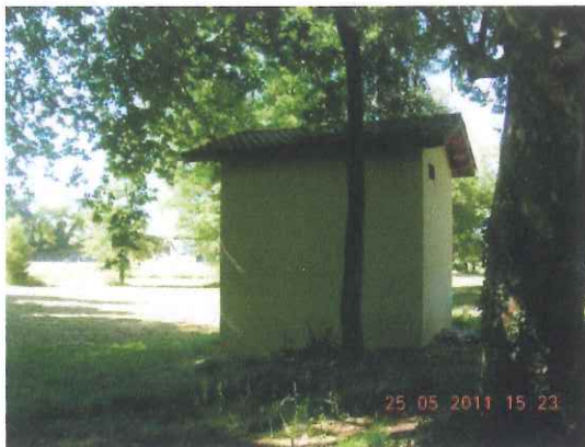
Station de pompage pour la cave viticole (P1)
