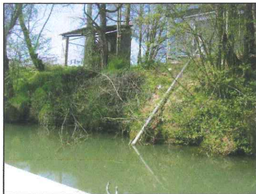
Station de pompage pour irrigation (P3)
