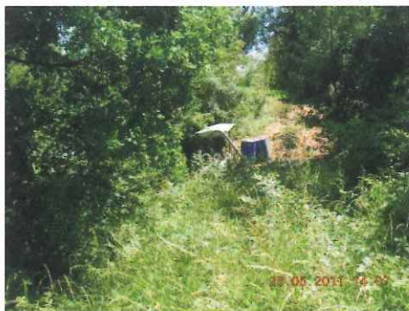
Station de pompage mobile pour irrigation (P5)
