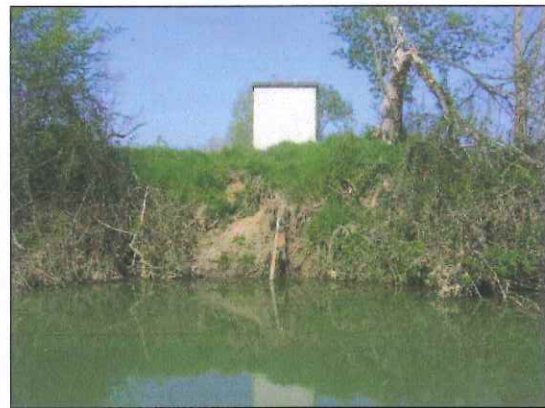
Station de pompage pour irrigation (P2)
